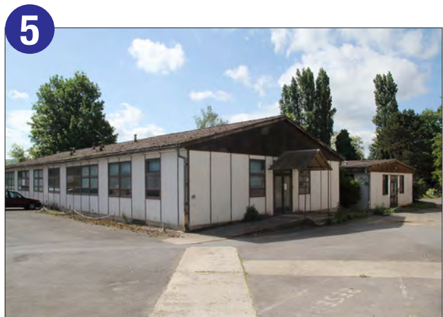
Bâtiments préfabriqués situés dans la Cour, en Rez-de-Jardin (bâtiments obsolètes voués à la démolition)
