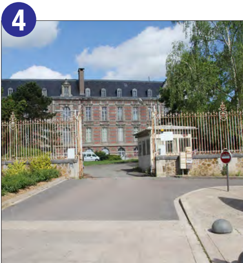
Entrée en Rez-de-Jardin, côté Avenue Joussaume-Latour
