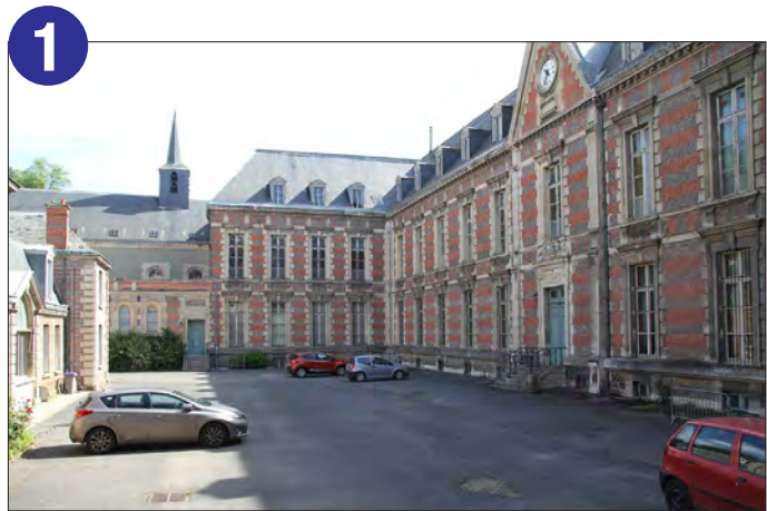
Cour en Rez-de-Chaussée du bâtiment principal de l'Hôtel-Dieu
